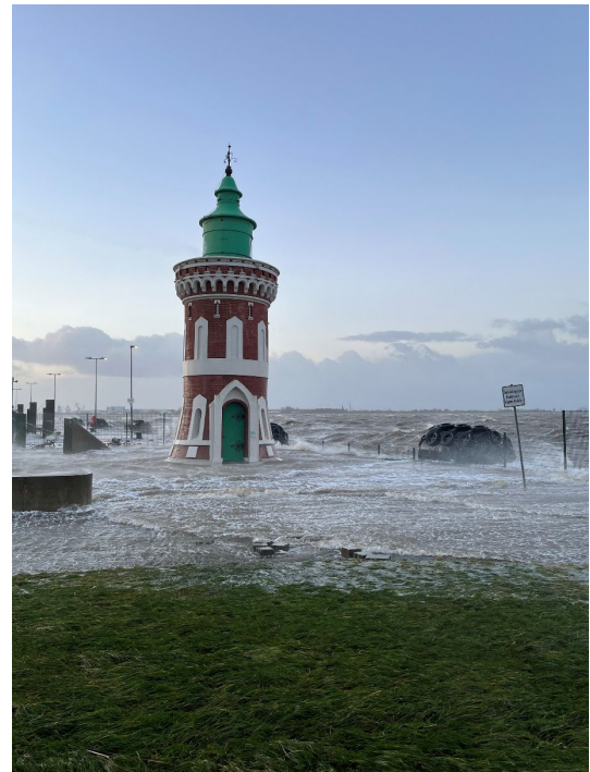
Hochwasser am Pingelturm am 22.12.2023
